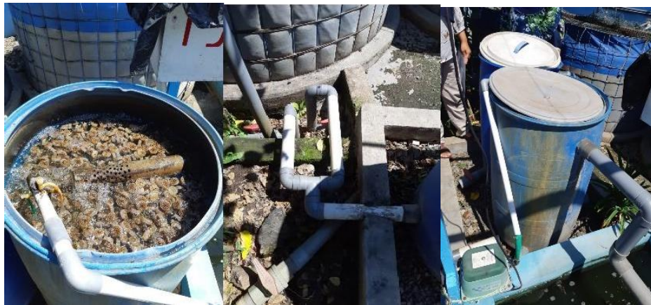
Gambar 5. Unit filtrasi RAS: (kiri) biofilter berisi media berpori; (tengah) jalur pipa & valve purge ; (kanan) dua drum filter (mekanik & biologis) dan return line ke kolam.3.1 Implementasi lapangan (kronologi intervensi)
