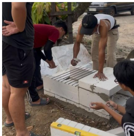
Gambar 1. Proses perakitan dan penataan bagian prototipe rocket stove.
