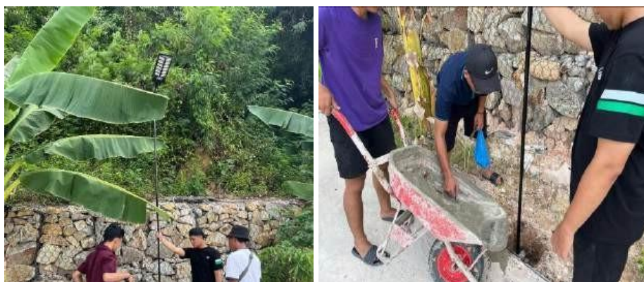
Gambar 2. Dokumentasi Pemasangan Lampu Jalan Tenaga Surya di Kelurahan Sekanak Raya
