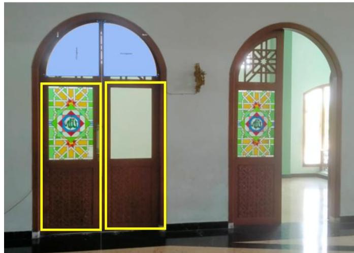
Gambar 9. Pintu Utama Lantai 2 Masjid
